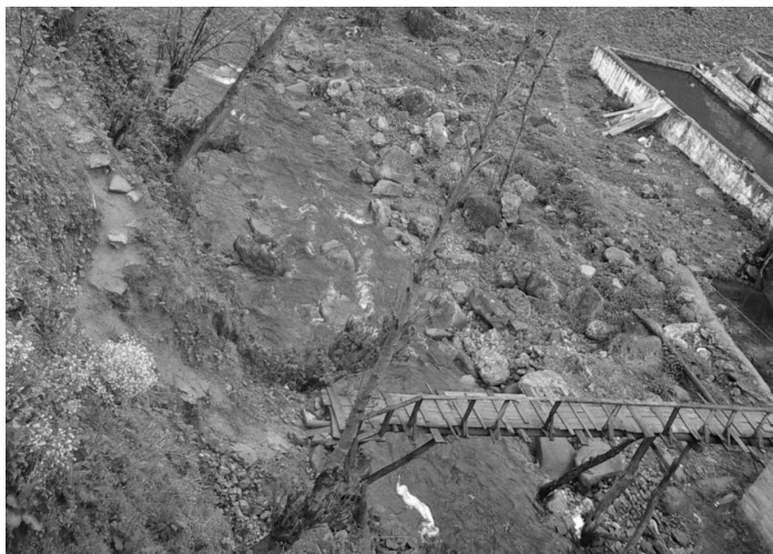
Photo 24 : Torrent passant en contrebas de la pisciculture
